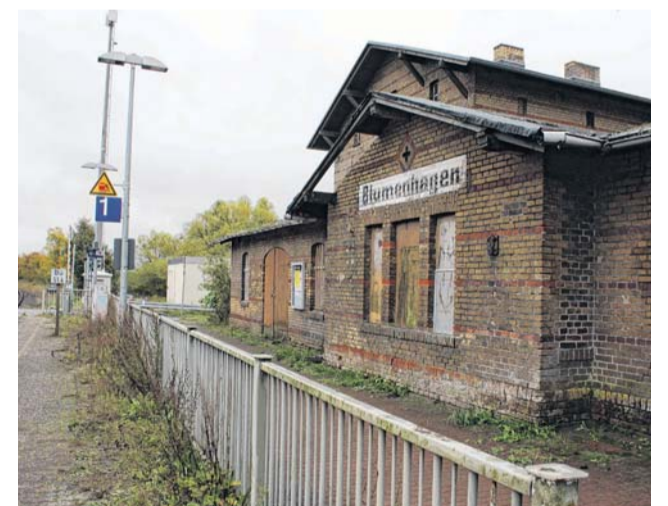
Der Bahnhof Blumenhagen wird nicht mehr genutzt. Er ist verbarrikadiert. Nach dem Unfall am Montag war er Anlaufstelle für die 42 Reisenden. Von hier aus setzten sie ihre Fahrt mit Bussen fort. FOTO: RAINER MARTEN
